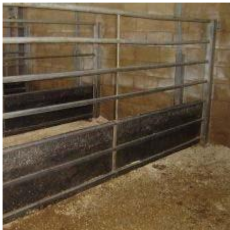
Рисунок 14. Загон с открытой стеной и панелью в основании
